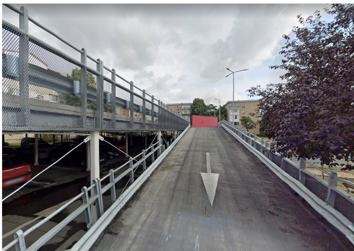
Figura 14 - Rampă acces/coborâre - Fast park 1 - Str. Tunarilor
